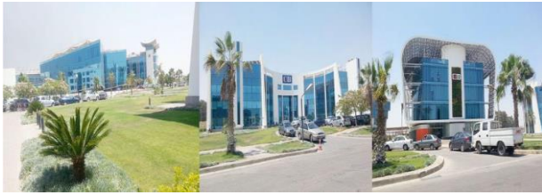
الشكل (١٥) - مبنى البنك التجاري الدولي CIB - القرية الذكية المصدر: https://www.cibeg.com/MediaCenter/Pages/PhotoGallery.aspx
