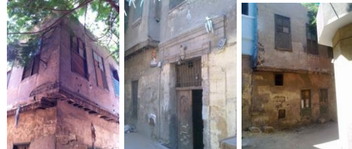
الواجهة الجانبية الواجهة الرئيسية الشبائيك الخشبية
